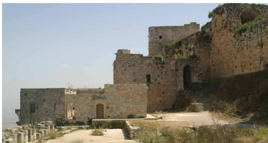
لوحة 20. المنطقة الشرقية للحصن الداخلي والمدخل
