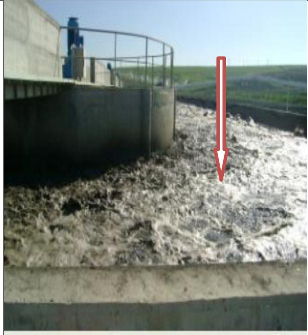
**Fig.III.10** Boue stabilisée
