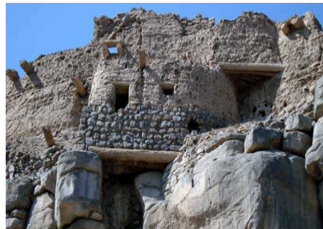
لوحة 9. معالجة عدم انتظام الكتل الصخرية
