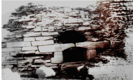
لوحة 4. مزغل بالبرج الجنوبي الشرقي
