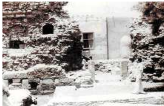
لوحة 2. مدخل قلعة قايتباي وجزء من الواجهة الجنوبية
