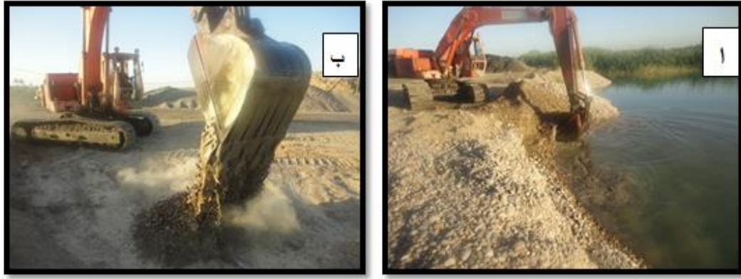
صورة (1-أ ، ب ) تظهر عملية الحفر بالحفارة الشوكية لغرض التقاط النماذج A ، B
