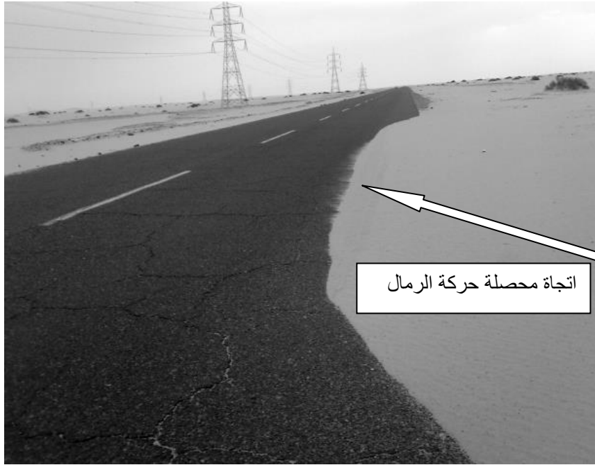
شكل (10): تراكم الرمال على الطريق المعبد بين سبها وبراك؛ لاحظ التراكم على الجزء الشرقي من الطريق.
