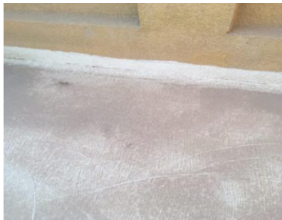
صورة رقم (٢) الياف الزجاج المقطعه صورة رقم (٣) مادة الطلاء على سطح المنزل
