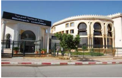
الصورة رقم 03: المدخل الخلفي الخاص بالموظفين
