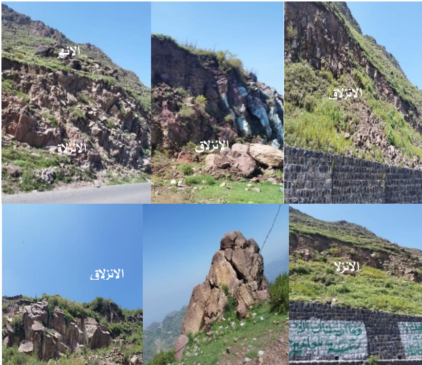
لوحة (15): نماذج لحالات الانهيار الانقلابي والانزلاق المستوي والانزلاق الإسفيني نتيجة لكثرة الشقوق والفواصل (الانقطاعات) في صخور المنحدرات المطللة على الجانب الأيمن لطريق نقيب سُمارة في المنطقة الرابعة. المصدر: الدراسة الميدانية بتاريخ 12-8-2021م.
