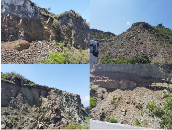
لوحة (12): نماذج لحالات الانزلاق المستوي للصخور والحطام الصخري والترتبة في المنحدرات المطلة على الجانب الأيمن لطريق نقييل شمارة في المنطقة الرابعة. المصدر: الدراسة الميدانية بتاريخ 2021-8-12م.
