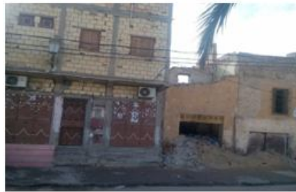
( استعمال مواد بناء حديثة لترميم بنايات داخل القصر)
