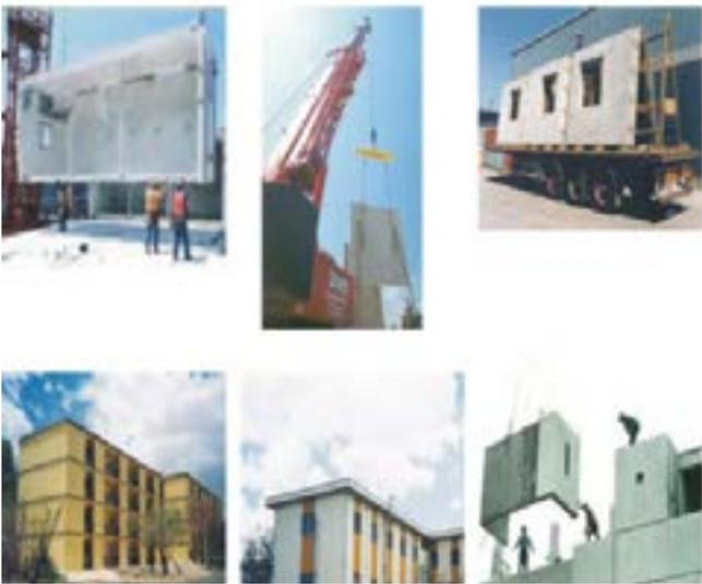
图9 也门现代建筑预制混凝土结构
