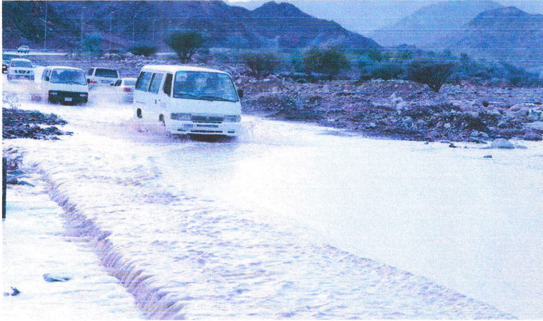
شكل-1: فشل التصميم الهيدرولوجي للطريق
