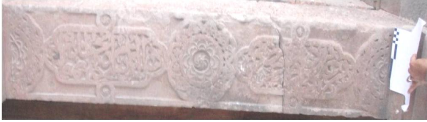
صورة (١ - أ) باطن عتب المدخل الجنوبي للمدرسة
