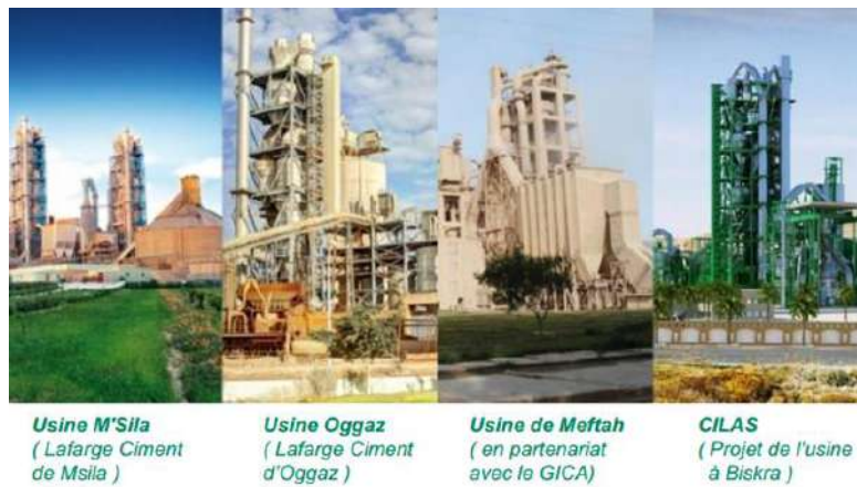
Fig.01 : les cimenteries de Lafarge en Algérie Source: www.lafarge.dz
