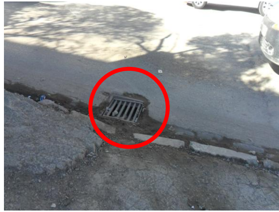
شكل(9): فتحات تصريف المياه
